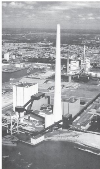
Figura 1.2 Central termoeletrica Esbjerg, Dinamarca. (Cortesia da Vestkraft, 1996.)
