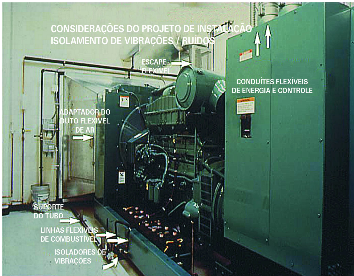
Figura 6-1. Provisões Anti-Vibração para um Grupo Gerador Típico
