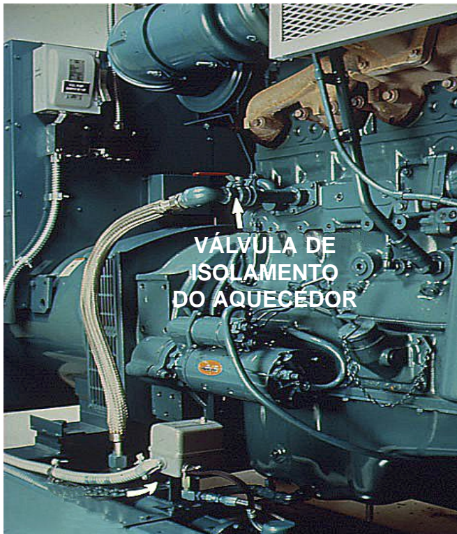
Figura 4-21. Instalação do Aquecedor na Jaqueta de Água. Note a Válvula de Isolamento do Aquecedor, e o Tipo e o Percurso da Mangueira.
